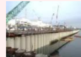
海側遮水壁 鋼管矢板打設完了状況
