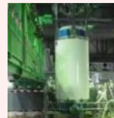
燃料取り出し状況
