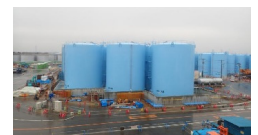
(溶接型タンク設置状況)
