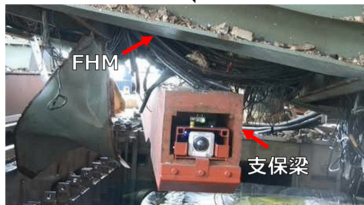
II-a. 支保梁挿入中 (撮影日：2020.10.20)
