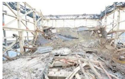
南側崩落屋根の状況
