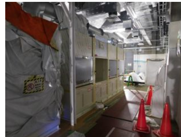
フード室 整備状況 2020.9.30
