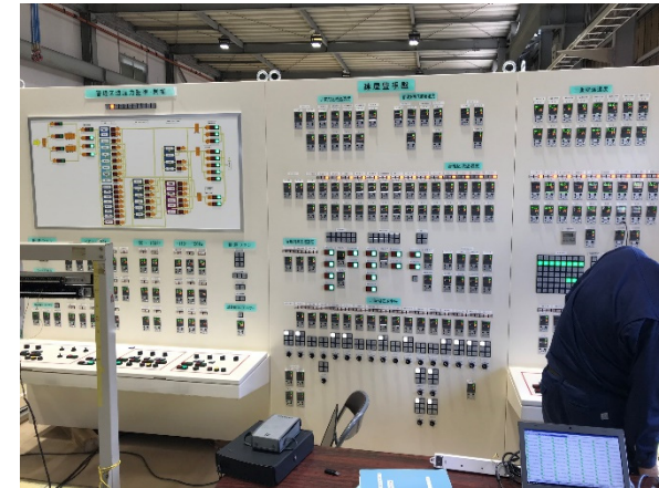
監視設備室 建屋監視盤 外観状況 2020.7.30
