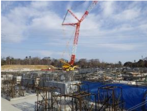
① 建屋 基礎工事状況(2018/3/14)
