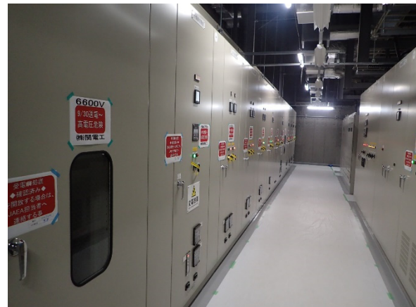
電気室 受電完了後の状況 2020.9.30
