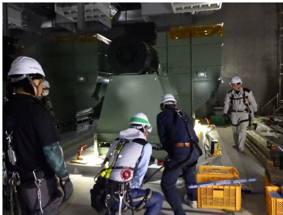
衛生空調機械室 送風機据付作業 2020.7.6
