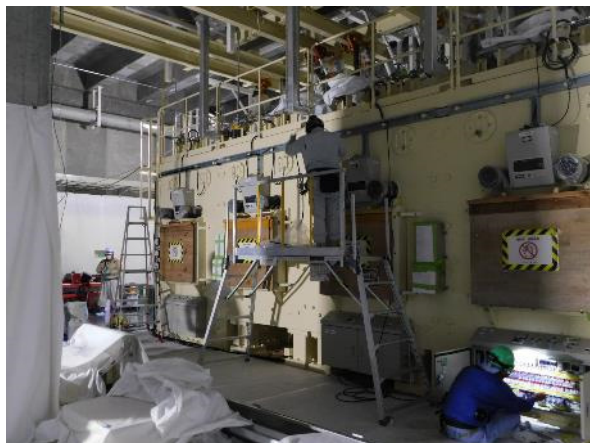
鉄セル室 付属品、盤類取付作業 2020.8.28
