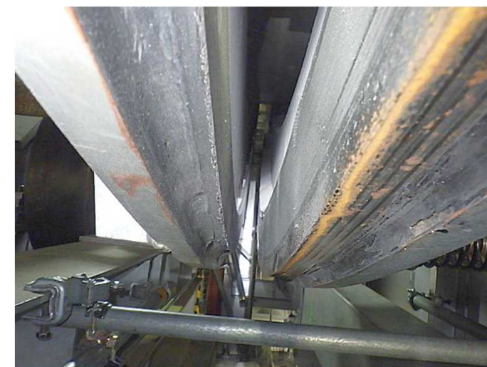
キルンシール部分解調査状況
