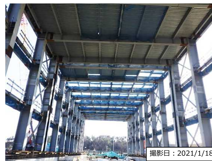
屋根工事の状況（内部より）
