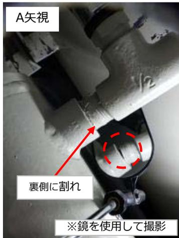
①損傷箇所（継手の付け根が割れ）
