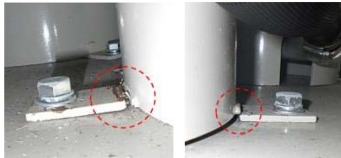
②損傷箇所（固定部割れ）
