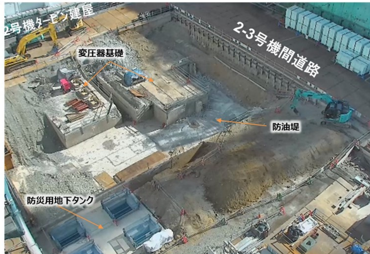
2号機原子炉建屋南側ヤード状況（撮影日：2021年1月30日）
