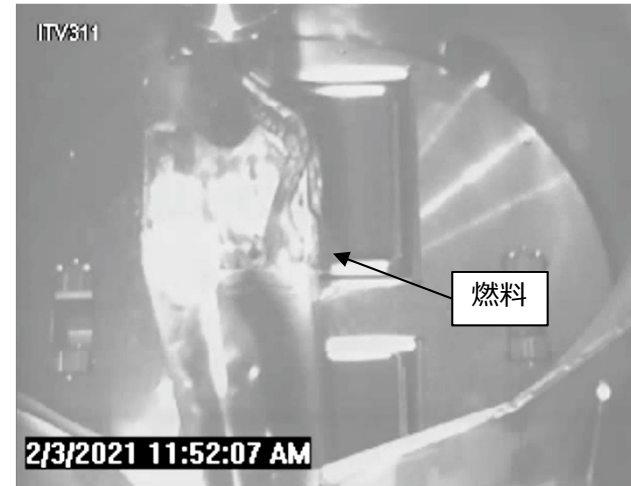
3号機での輸送容器への装填
