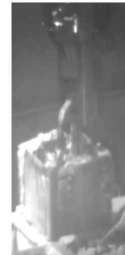
吊り上げ状況
