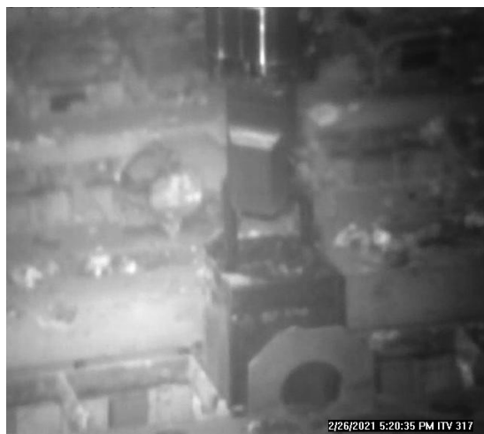
3号機での燃料の吊り上げ（566体目）
