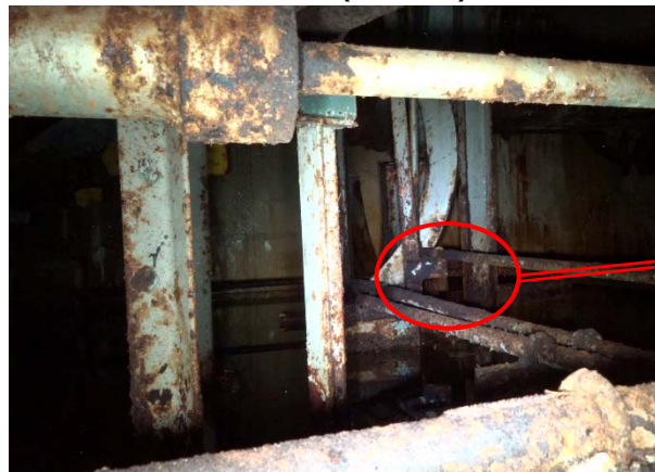
主蒸気配管D（主蒸気配管Cの奥側）
