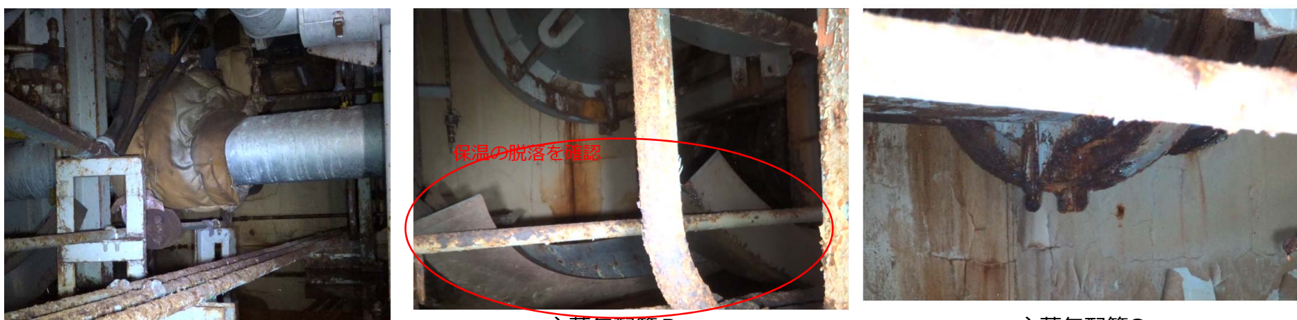
主蒸気系ドレン配管
