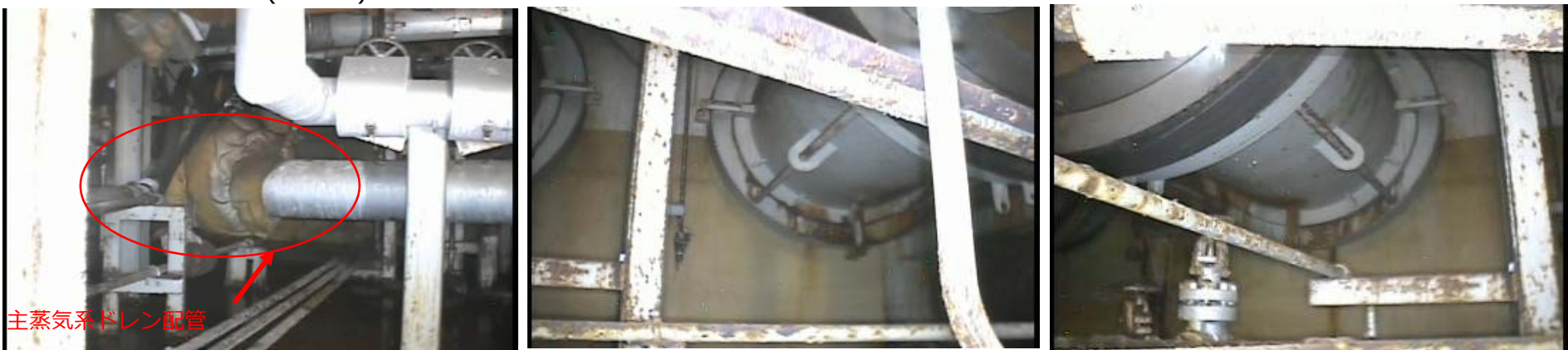
主蒸気系ドレン配管
