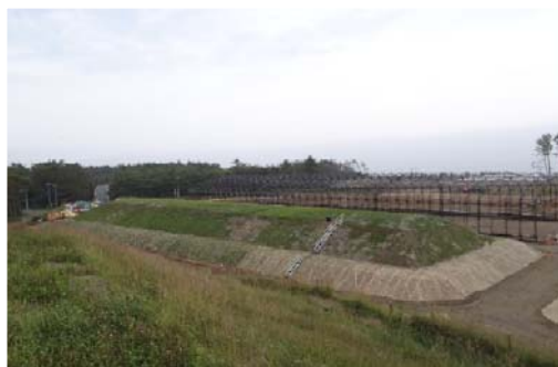
覆土式一時保管施設
