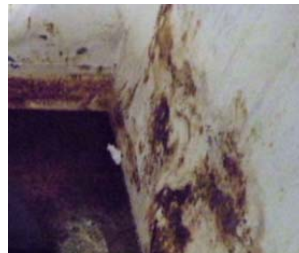
図16. 容器内面・補修箇所の状況
