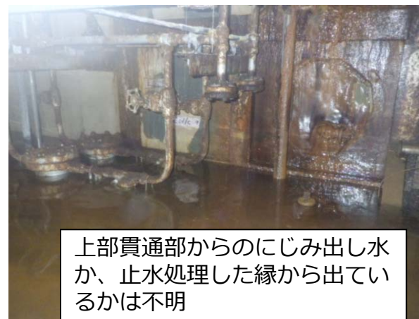
⑬漏水箇所
