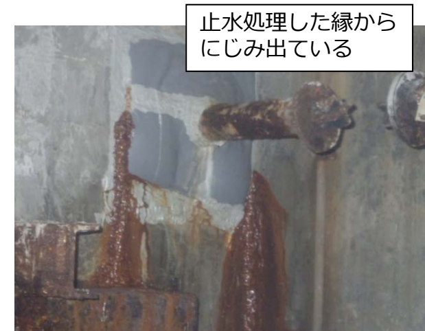
②漏水箇所
