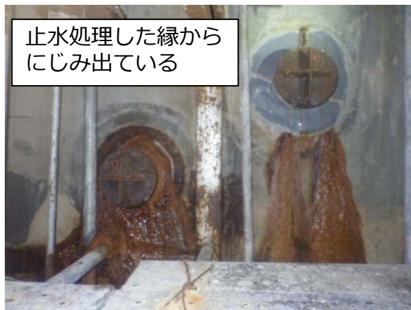
⑩⑫漏水箇所
