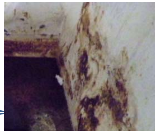
容器内面・補修箇所の状況
