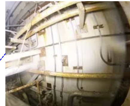
写真3D: プール壁西面
