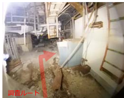
写真3B: プール壁の南西部
