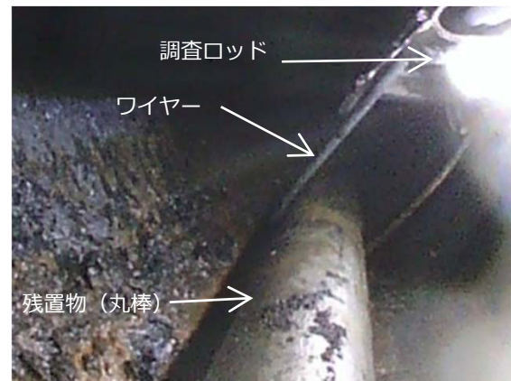
残置物（丸棒）の撤去時の状況
