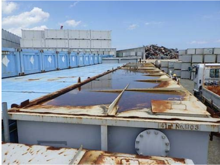
ノッチタンク上部の状況 (2021.7.6撮影)
