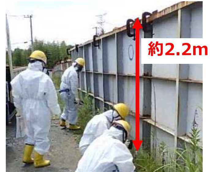
<ノッチタンクの設置状況>
