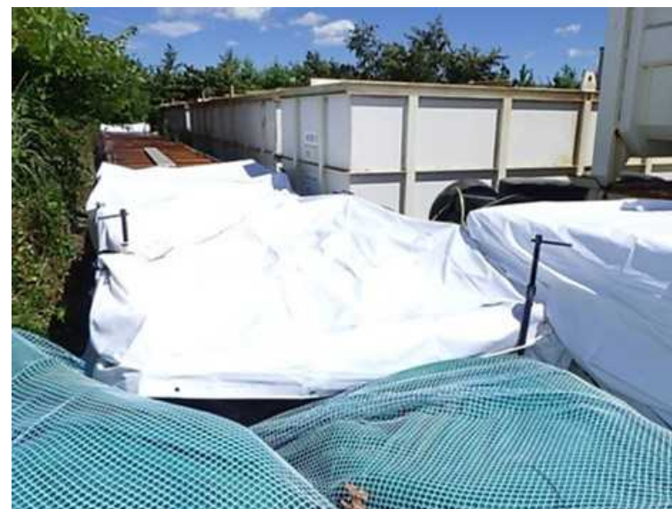
シート養生後
