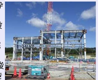
<建設状況（2021年10月20日撮影）>
