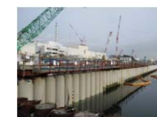
海側遮水壁打設完了の様子
