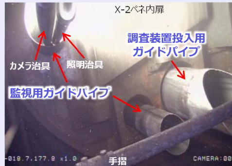
<ガイドパイプ設置状況>
