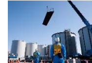
溶接タンク建設中の様子
