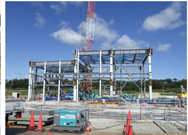
鉄骨工事 (2021/10/20撮影)
