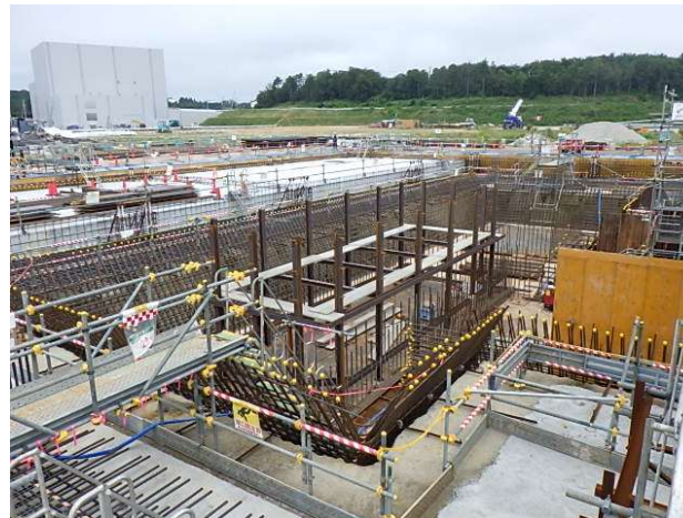
基礎工事 (2021/8/20撮影)
