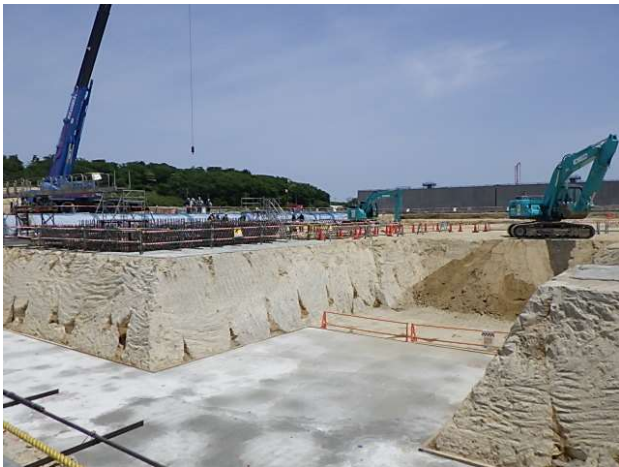
地盤改良・掘削 (2021/5/14撮影)
