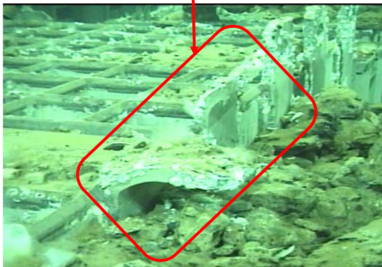
吊りピース変形
