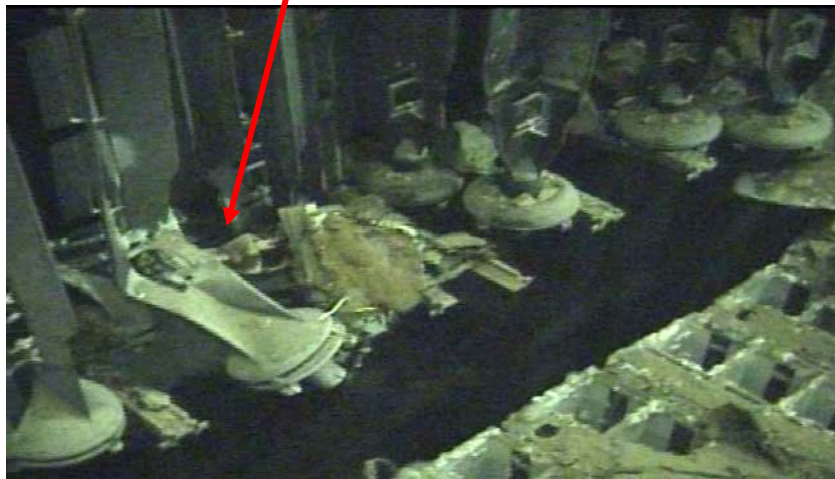
制御棒下部に変形
