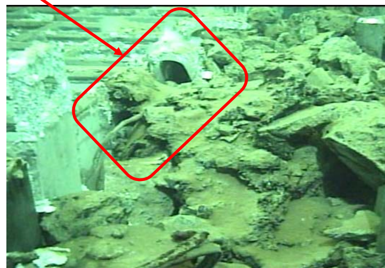
吊りピース変形
