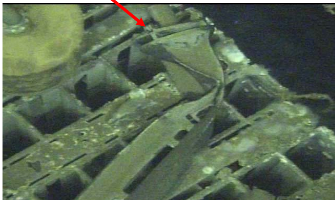
制御棒下部に変形
