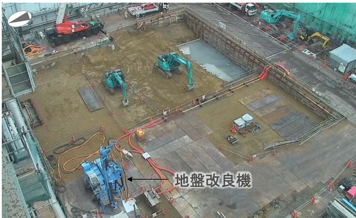
2号機原子炉建屋南側ヤード状況（撮影日：2021年11月10日）
