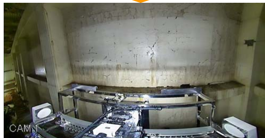
高所壁面除染後
