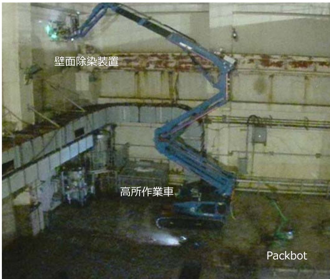
高所壁面除染実施状況※
