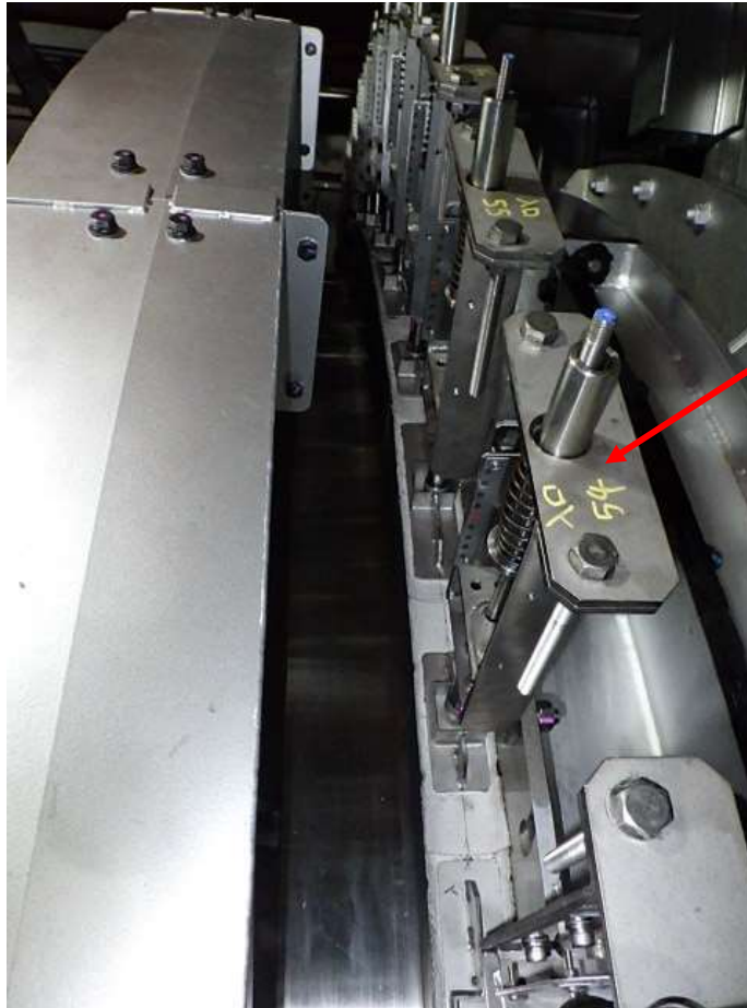
実機組付状況
