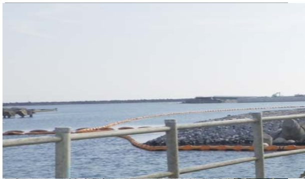
（既設）重油オイルフェンス展張状況
