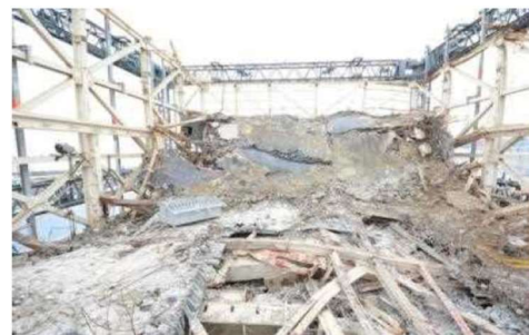
南側崩落屋根の状況
