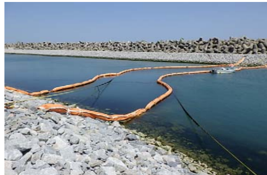
（既設）5・6号機取水路開渠シルトフェンス展張状況
