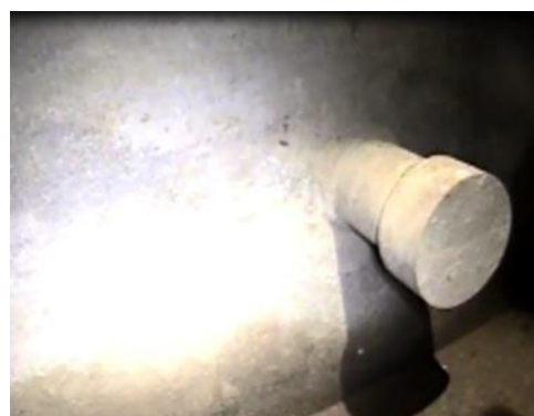
①出口配管
