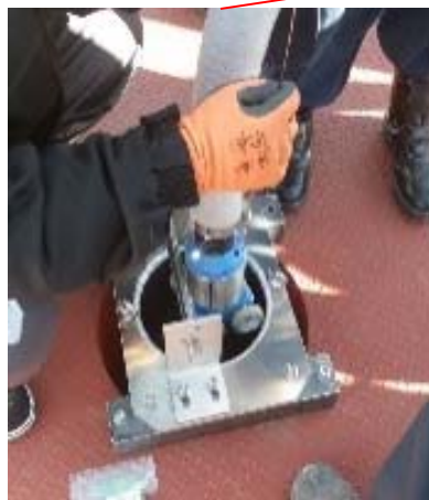
配管内アクセス装置挿入(3階)
