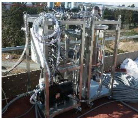
ポンプユニット
