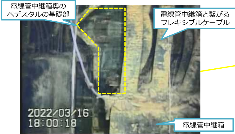
写真1.ペDESTAL基礎部付近の状況①
