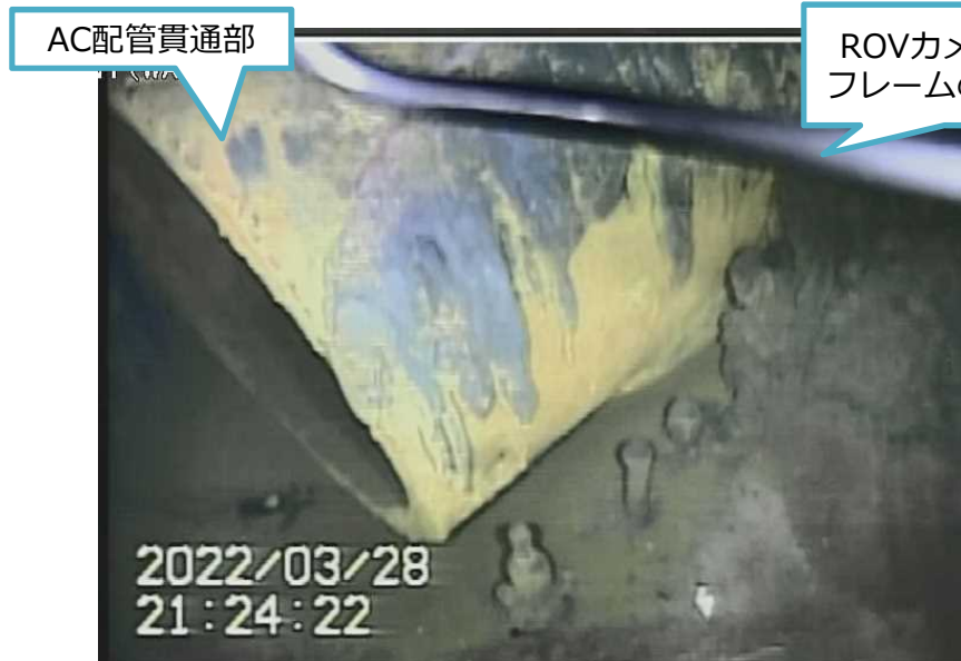
写真2.AC配管貫通部の状況
