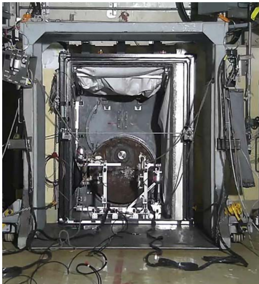
隔離部屋①の設置状況
