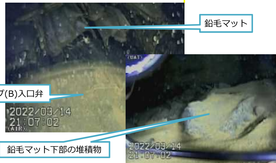
写真3. PLRポンプ(B)入口弁付近の状況
