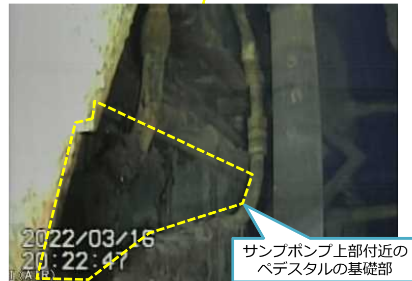
写真3.ペDESTAL基礎部付近の状況②
