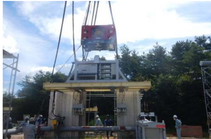
装置一式 (吊り天秤、切断装置等)
