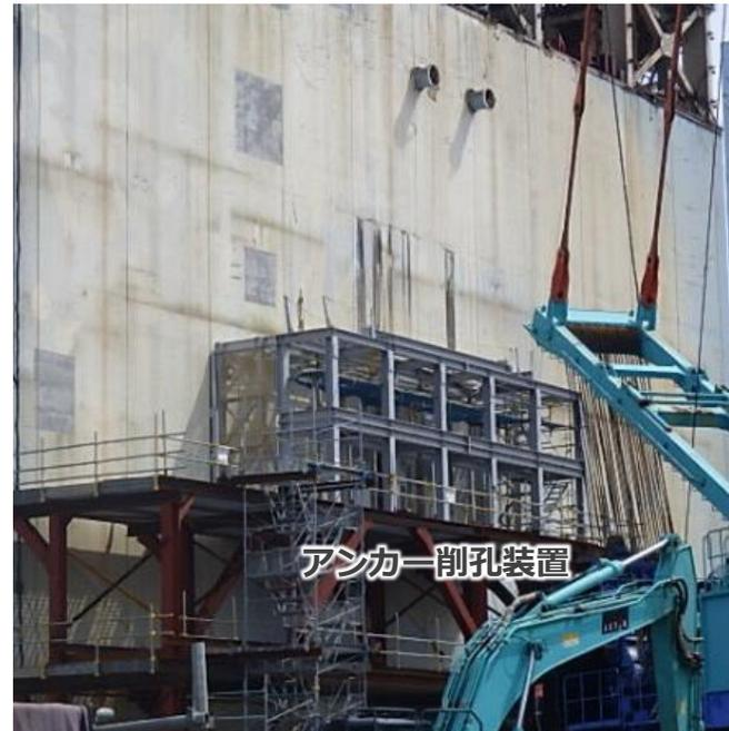
アンカー削孔装置
