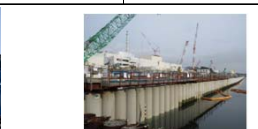
海側遮水壁打設完了の様子
