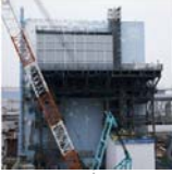
<2号機 燃料取り出し用構台建設中の様子>
