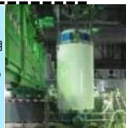
燃料取り出し状況
