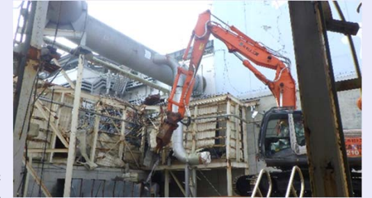
<ガレキ撤去作業の様子>
