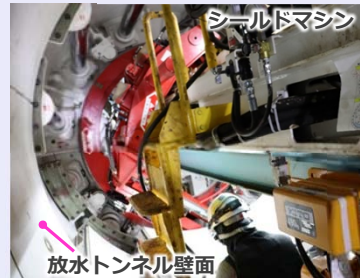
放水トンネル壁面 シールドマシン内部で後方から前方部を撮影 <シールドマシン掘進作業の状況>
