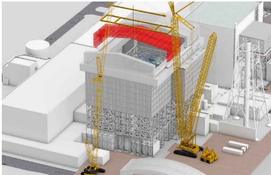
可動屋根設置中
