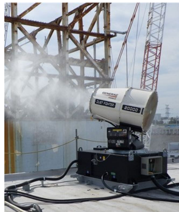
噴霧装置による散水状況
