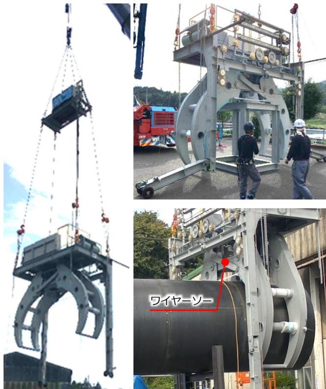
写真④：主排気ダクト切断装置
