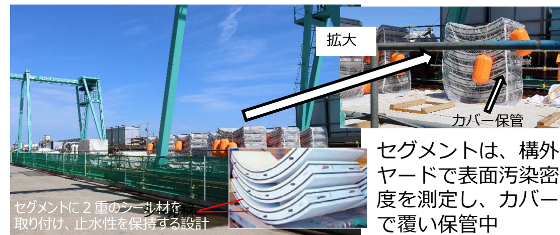
セグメント保管状況
