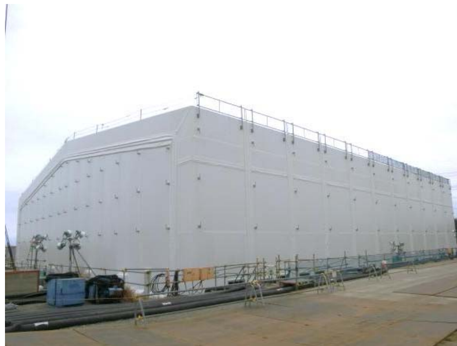
既設多核種除去設備(既設ALPS)
