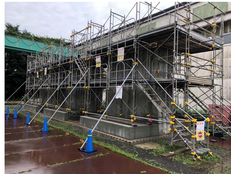
写真1. 試験体構築完了
