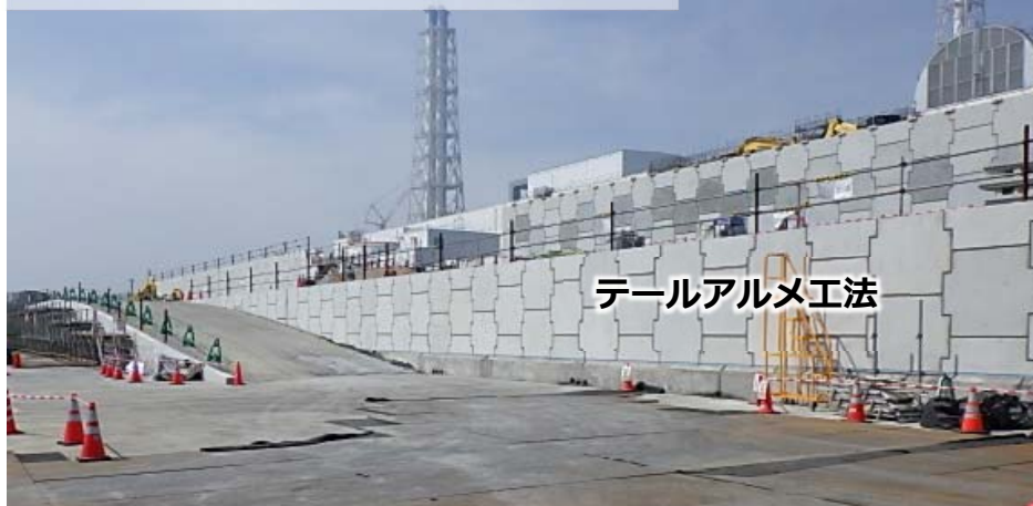
コンクリート壁設置状況
