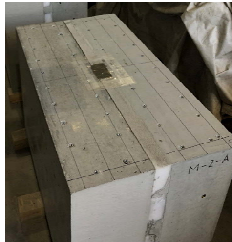
手順5：止水材（モルタル）注入完了
