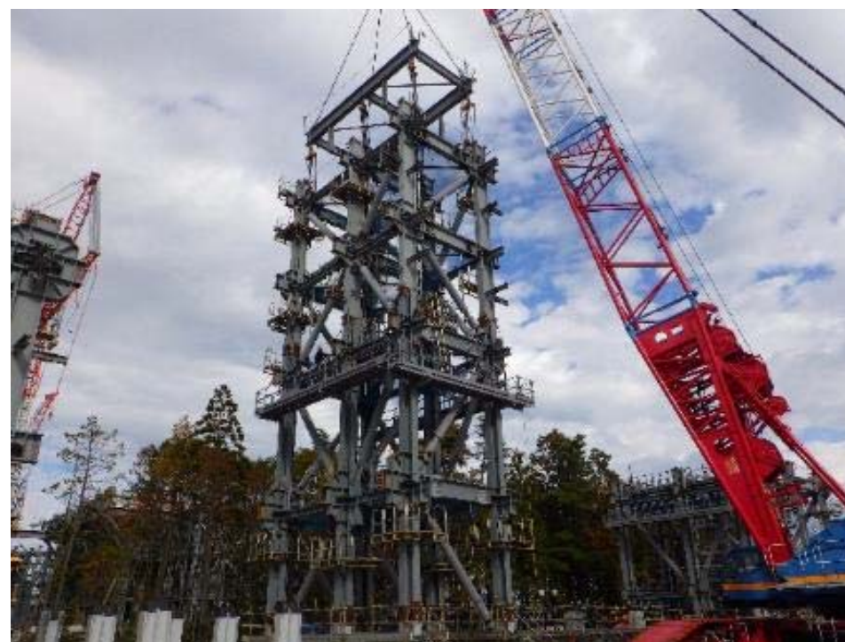
鉄骨ユニット接合確認状況（撮影：2022.11.5）
