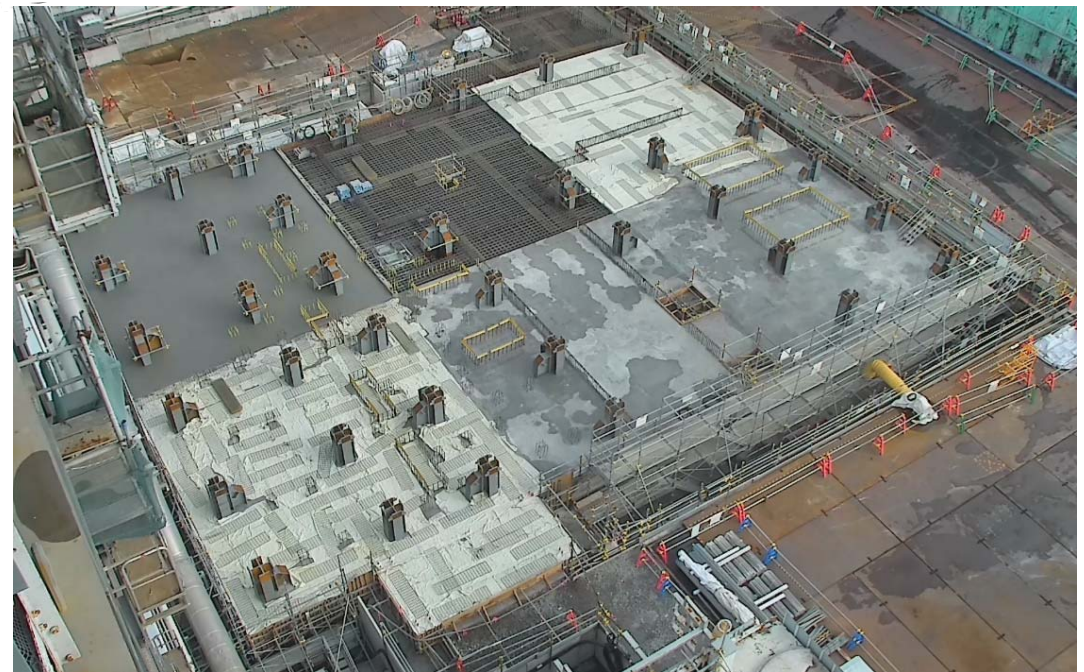
2号機原子炉建屋南側ヤード全景 (撮影：2022.11.21)
