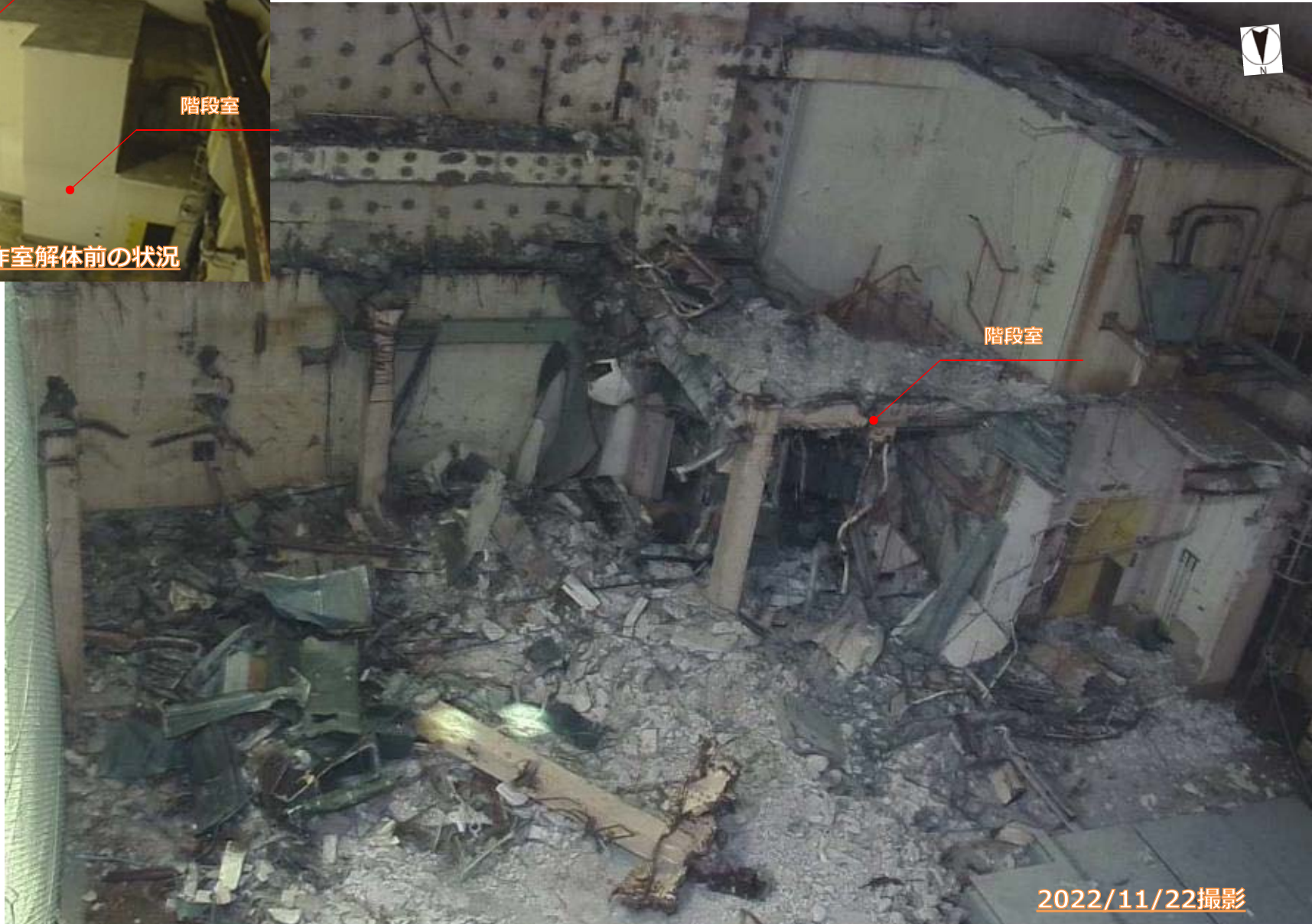
解体中の現場状況写真
