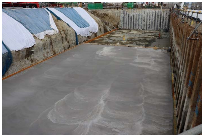
均しコンクリート打設の状況
