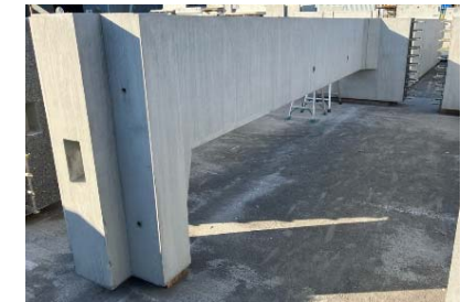
上流水槽隔壁
