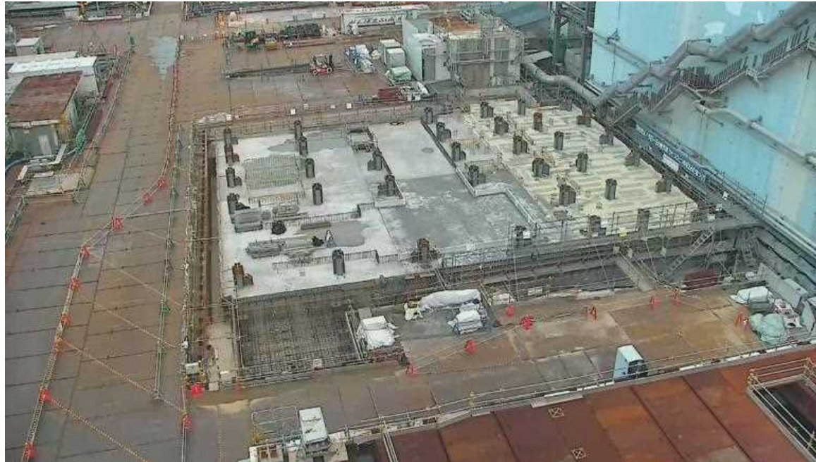
2号機燃料取り出し構台設置に 合わせてフェーシング実施中
