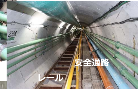
トンネル内部安全設備の整備状況
