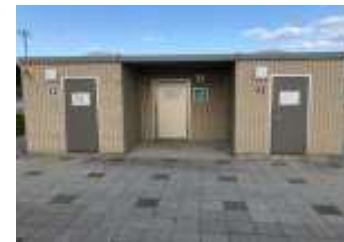
バリアフリー化の対象となる現地のトイレ棟 64
