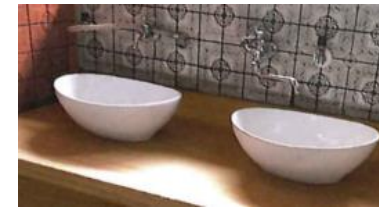
改修した洗面設備
