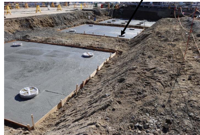
海水移送配管基礎の構築状況
