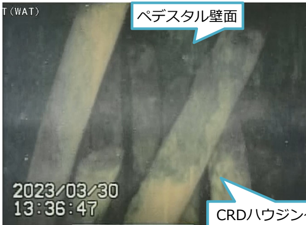
写真2. CRDハウジングと思われる構造物
