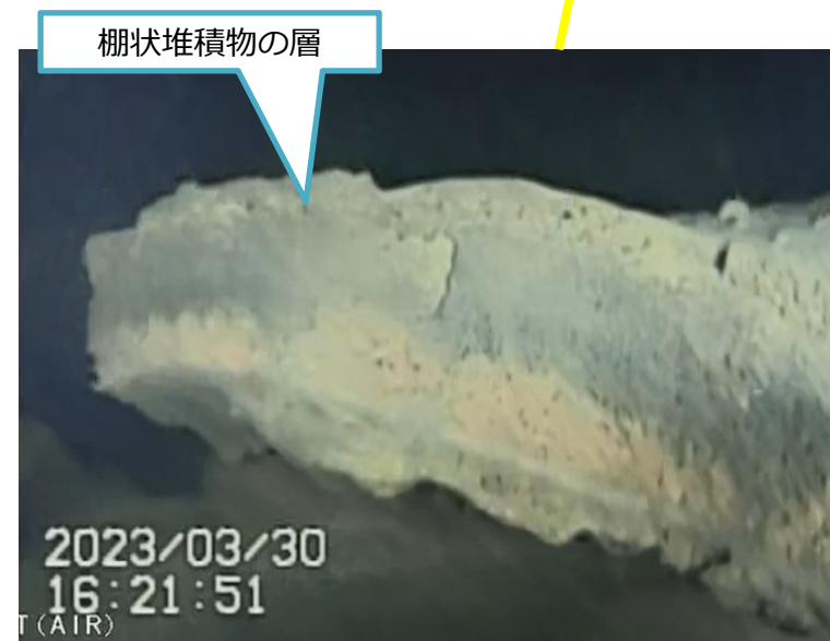
写真3. ペDESTAL外棚状堆積物断面
