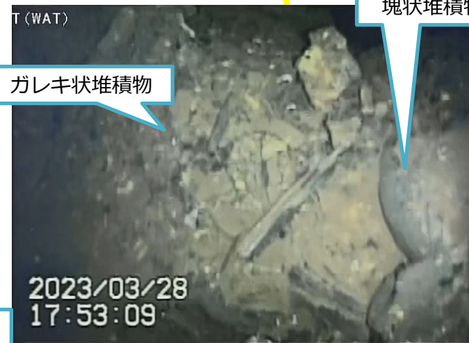
写真3.ペDESTAL内開口付近堆積物
