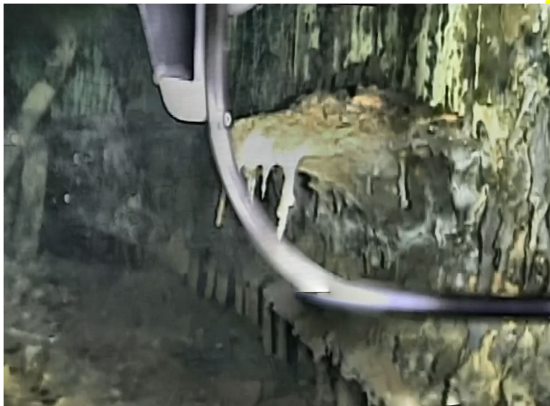
写真2 (パノラマ) 開口部右側の棚状堆積物
