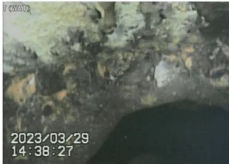
写真2 棚状堆積物の縁の状態（その2）
