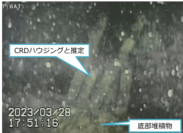
写真1. CRDハウジングと思われる構造物
