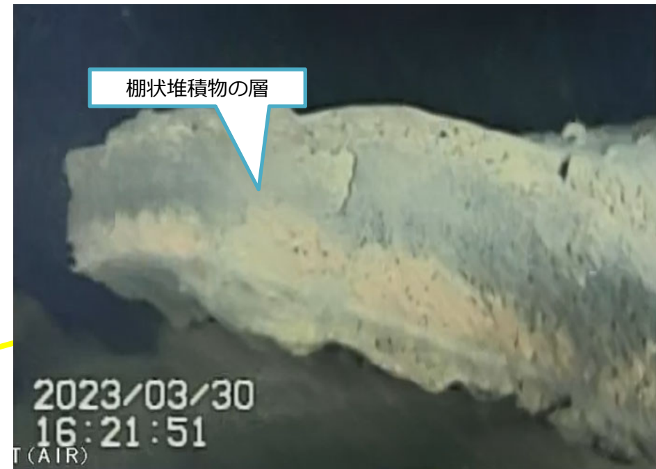
写真1. ペDESTAL外棚状堆積物断面
