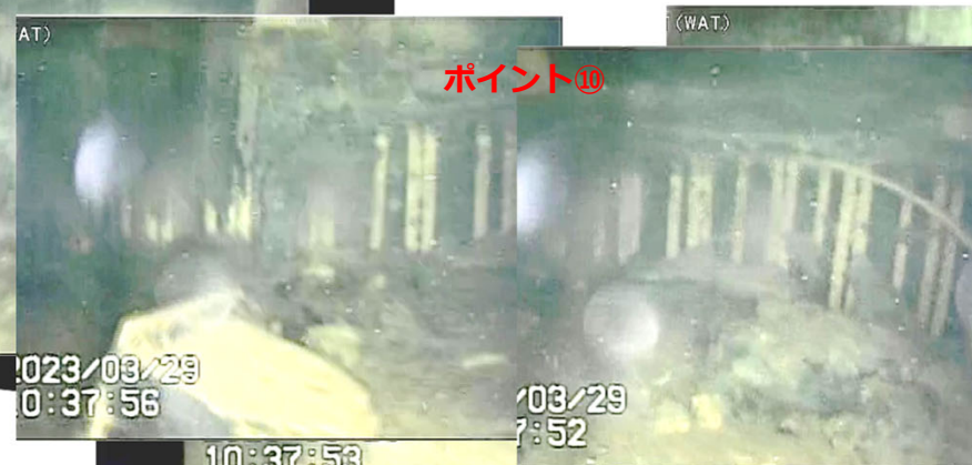
写真2. ポイント⑨、⑩ペDESTAL基礎部 画像処理：東京電力ホールディングス(株)
