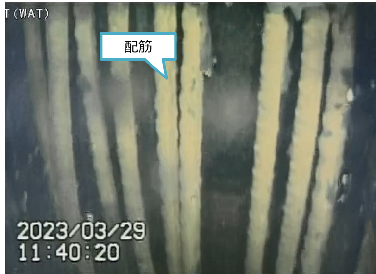
写真2.ペDESTAL内壁面部(下部)
