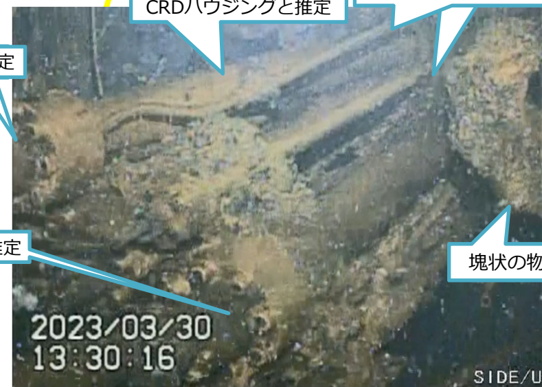
写真3. CRD関連と思われる構造物 (上部監視カメラで気中を撮影)
