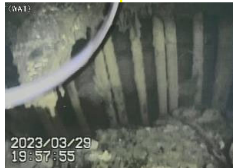
写真3 比較的に大きい棚状堆積物
