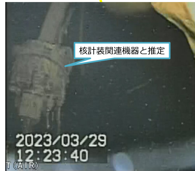
写真3. 核計装関連機器と思われる構造物 (気中監視カメラで気中を撮影)
