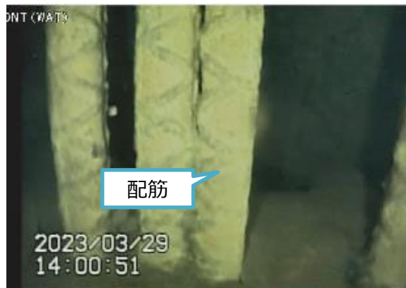
写真2. ポイント⑫ペDESTAL基礎部
