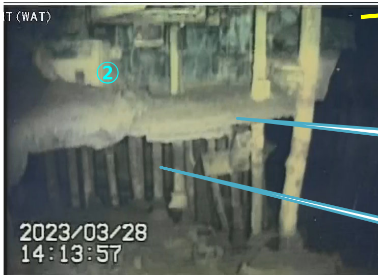
写真2.ペDESTAL開口部左下側壁面部
