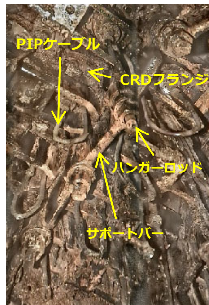
写真2. 2号機で確認されたCRD
