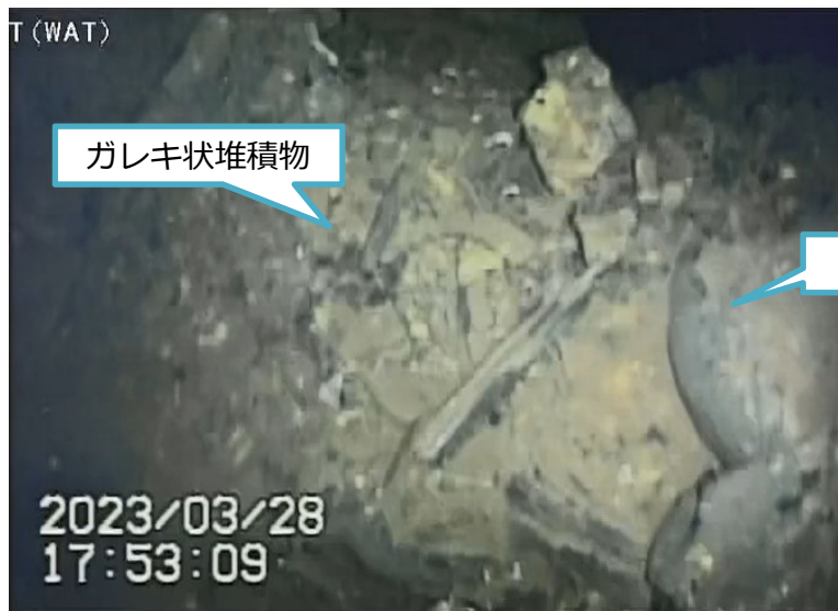
写真2.ペDESTAL内開口付近堆積物
