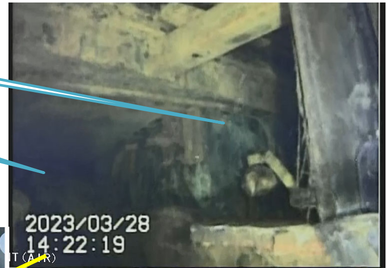
写真3.ペDESTAL開口部右上側壁面部
