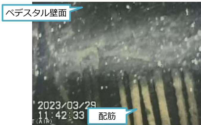
写真1. ポイント⑪ペDESTAL基礎部
