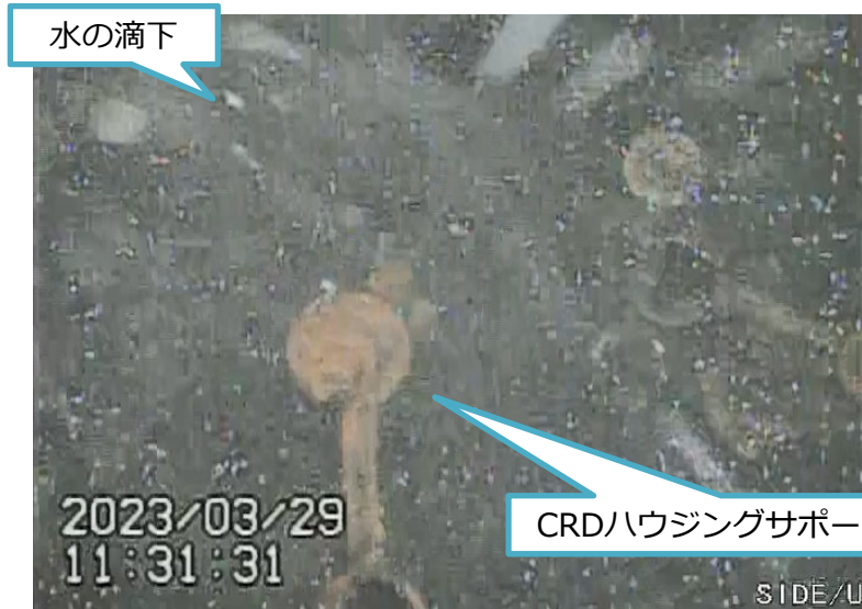
写真2. CRDハウジングサポートと思われる構造物 (上部監視カメラで気中を撮影)
