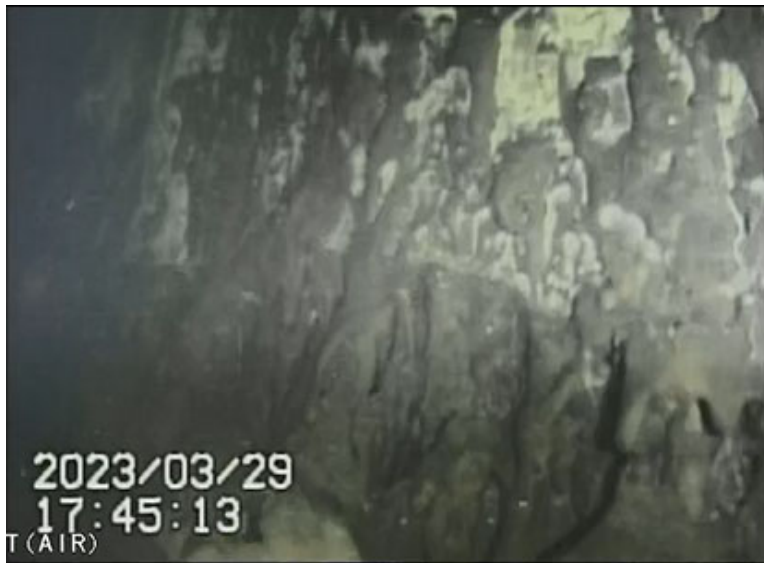
写真1 棚状堆積物のない壁面の状況
