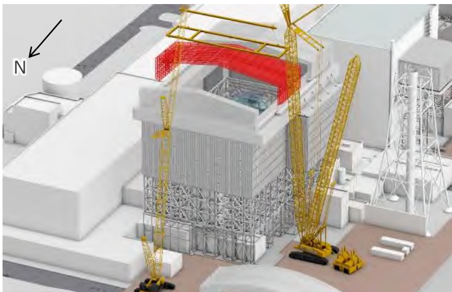
可動屋根設置中
