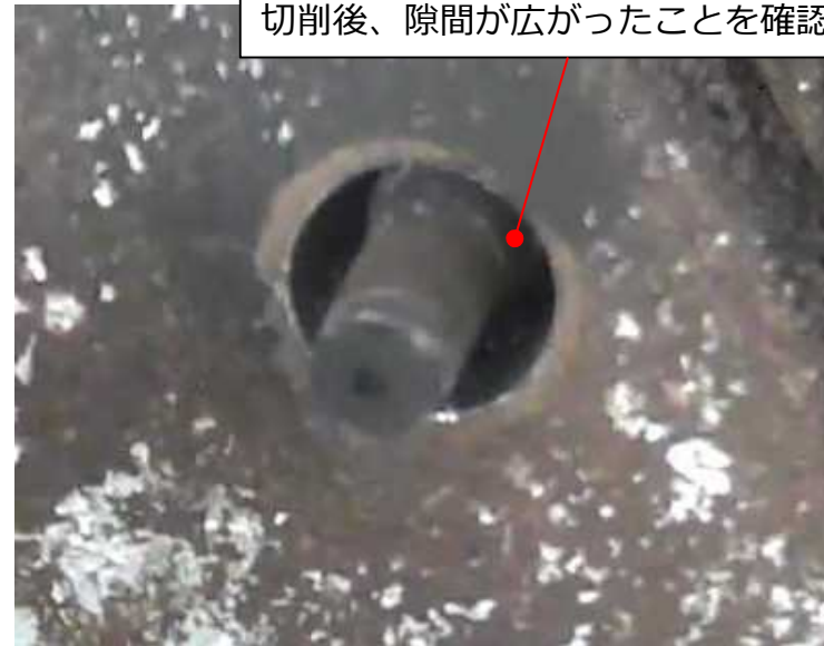
長尺ホールソー切削作業状況
