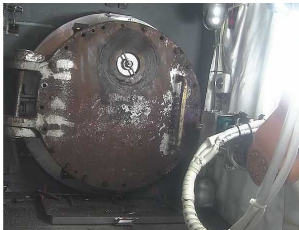
ボルト除去作業状況
