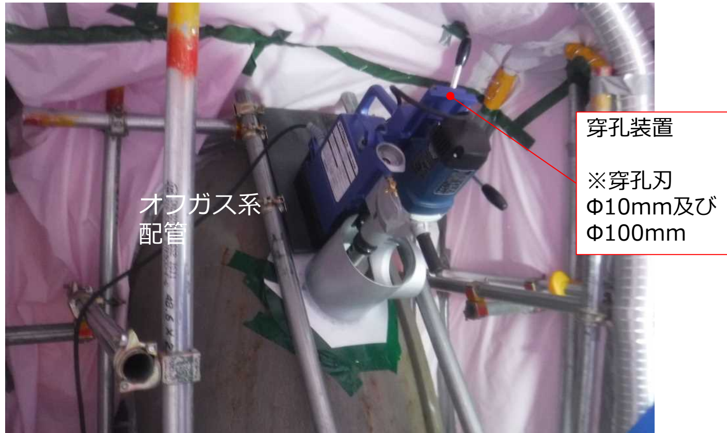
オフガス系配管の穿孔装置設置状況（1/2号機排気筒内部調査時）
