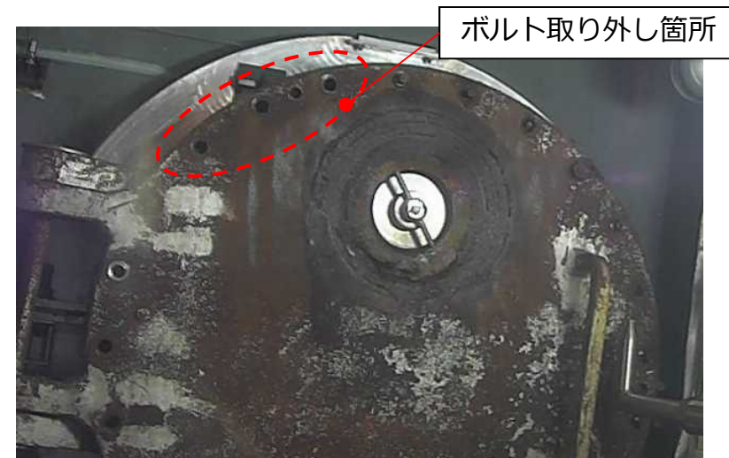
ボルト取り外し後
