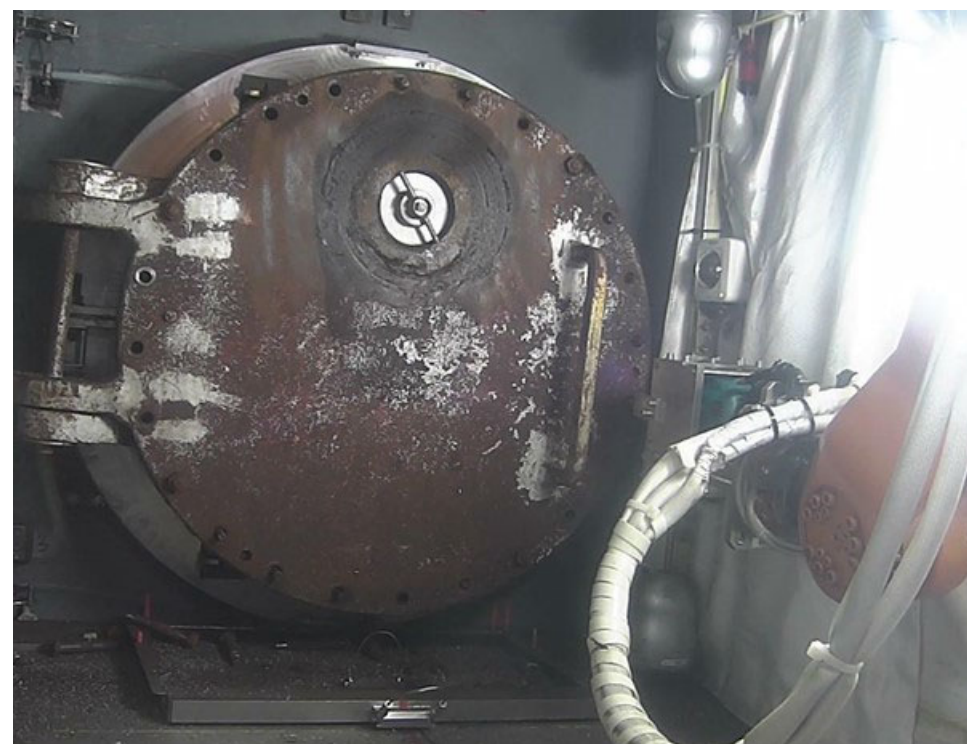
ボルト除去作業状況
