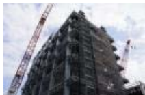
大型休憩所建設中 (2014年9月30日撮影)
