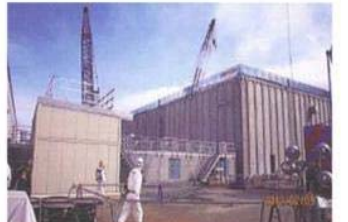
廃スラッジ一時保管施設
