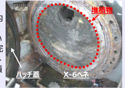
<X-6ペネハッチの開放後の状況>
