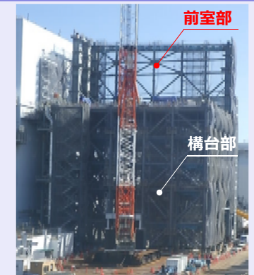
<2号機原子炉建屋南側の作業状況>(撮影日:2023年10月6日)
