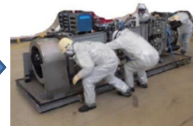
堆積物除去装置 (低圧水) 撤去
