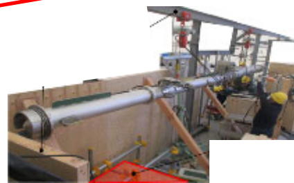
スプレー治具設置 ※X-53ペネに接続
