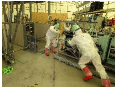
堆積物除去装置 (低圧水) 設置
