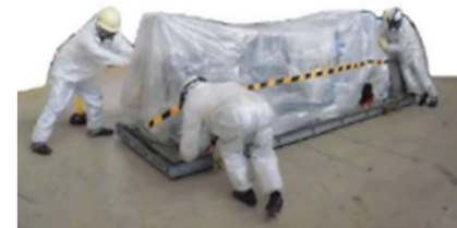
堆積物除去装置 (高圧水、AWJ) 撤去
