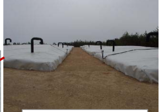
伐採木一時保管槽
