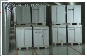
固体廃棄物貯蔵庫
