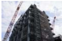
大型休憩所建設中 (2014年9月30日撮影)
