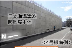
日本海溝津波防潮堤
