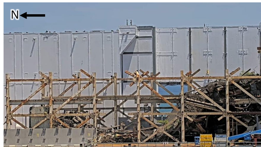
撤去後の全景（撮影：2025年5月23日）
