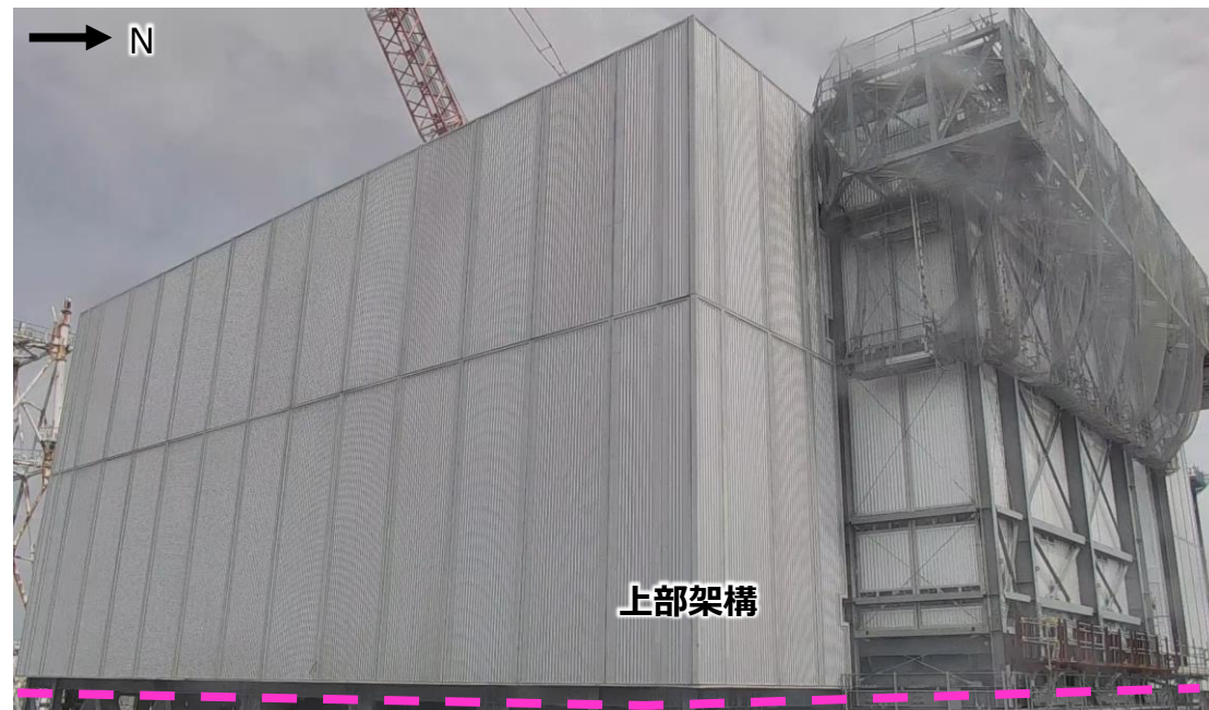
現場状況（南東面） （撮影：2025年6月30日）
