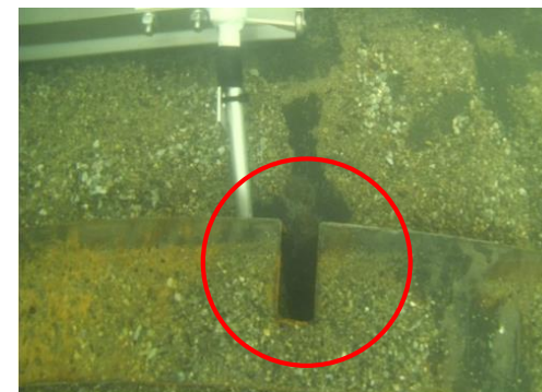
狭小箇所清掃後の状況
