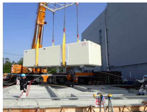
タンク設置作業の状況(2025年5月)
