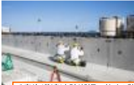
千島海溝津波防潮堤の仕上げ作業
