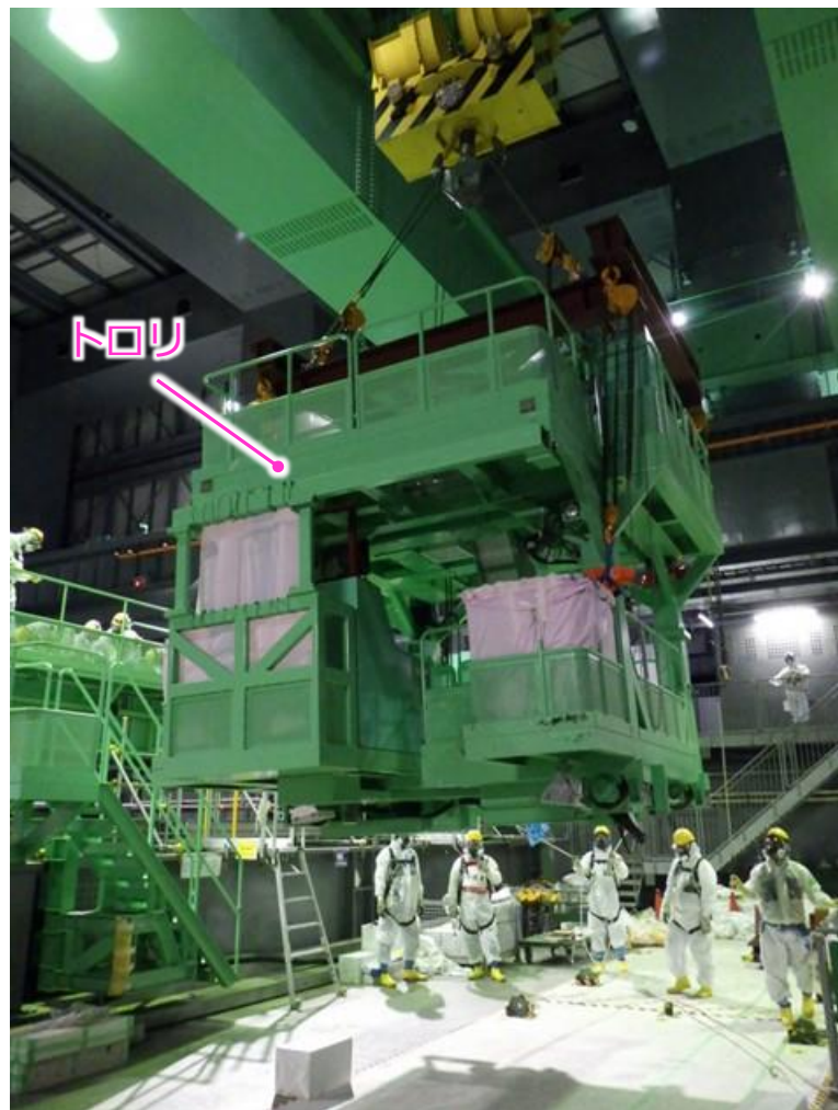
トロリ吊り上げ（撮影：2025年11月12日）
