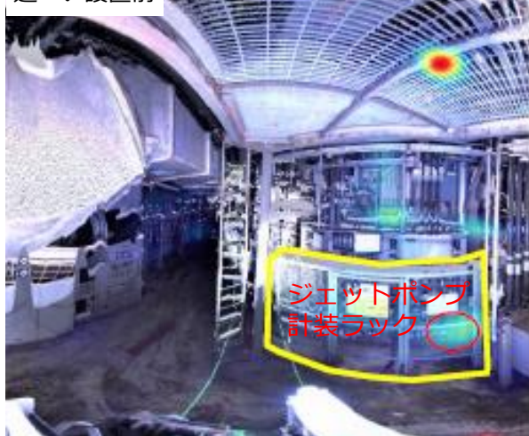
遮へい設置前
