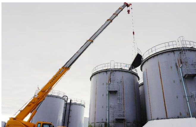
＜J8エリアタンクの天蓋を撤去する様子＞
