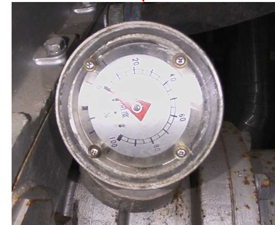
3B弁開度計（全閉表示）
