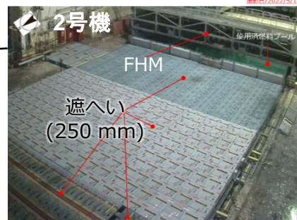
オペレーションフロアの遮へいの状況
