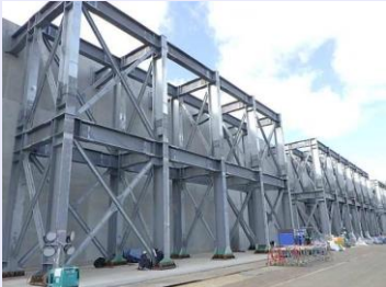
補強工事完了後の状況
