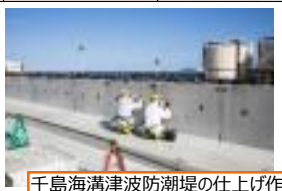
千島海溝津波防潮堤の仕上げ作業
